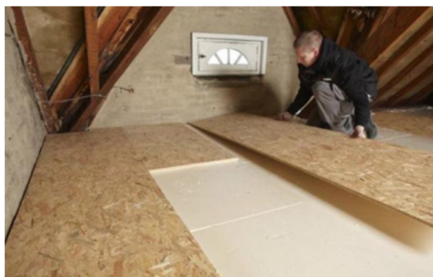
isolatie op de zoldervloer
