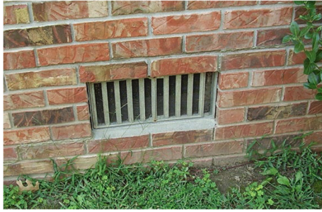
ventilatie-rooster kruipruimte
