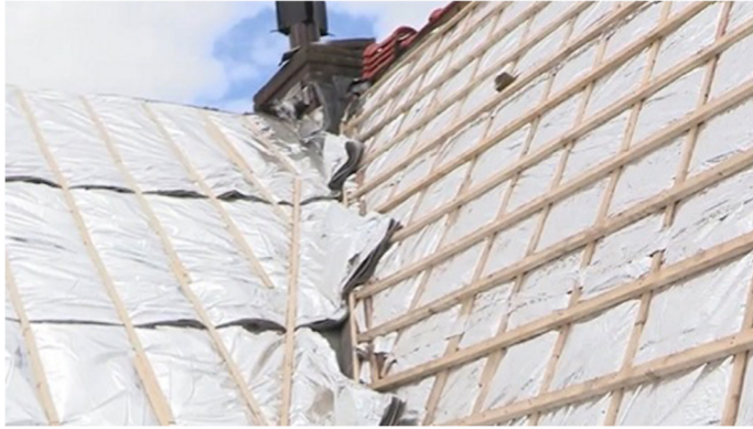
isolatie onder de dakpannen
