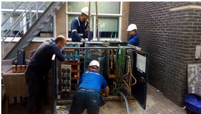
Meterkast aangepast voor aansluiting zonnepanelen. Foto: HilverZon
