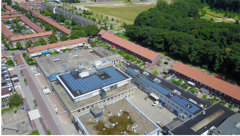
273 zonnepanelen op Rotor Mediagebouw, Arendstraat. Foto: HilverZon
